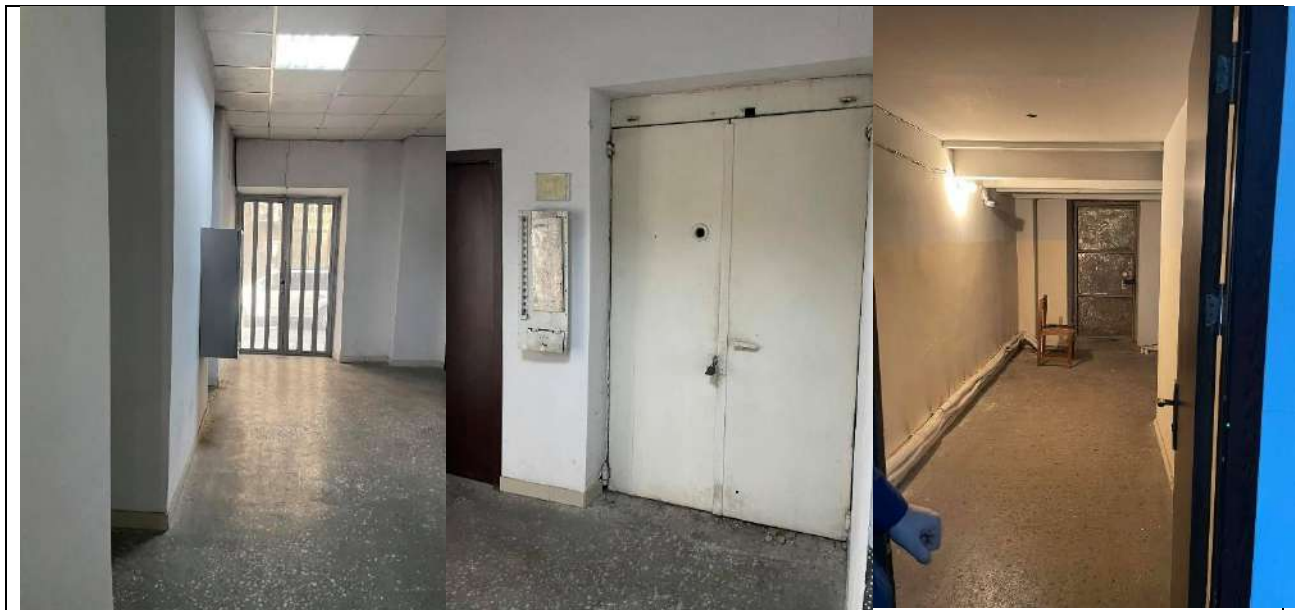
Պահուստային մուտք դեպի շենքի առաջին հարկ Բեռնատար վերելակ Պահուստային մուտք դեպի շենքի նկուղային հարկ
